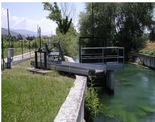
Fig. 2 - Opera di presa sul Fiume Clitunno
