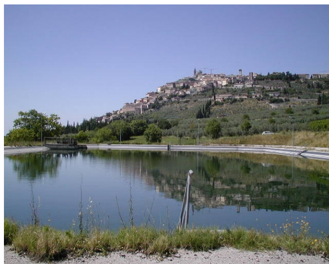
Fig. 3 - "Impianto di irrigazione a pioggia - Distretto di Cannaiola" - Vasca di compenso in Loc. Bovara di Trevi
